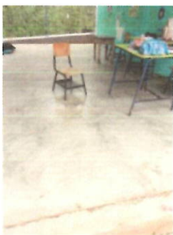
PISO, SUSTITUCION DE PISO EN MAL ESTADO, POR PISO DE GRANITO
