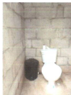
SERVICIOS SANITARIO, SUSTITUCION DE SERVICIO SANITARIO LAVABLE EN MAL ESTADO Y LAVAMANOS
